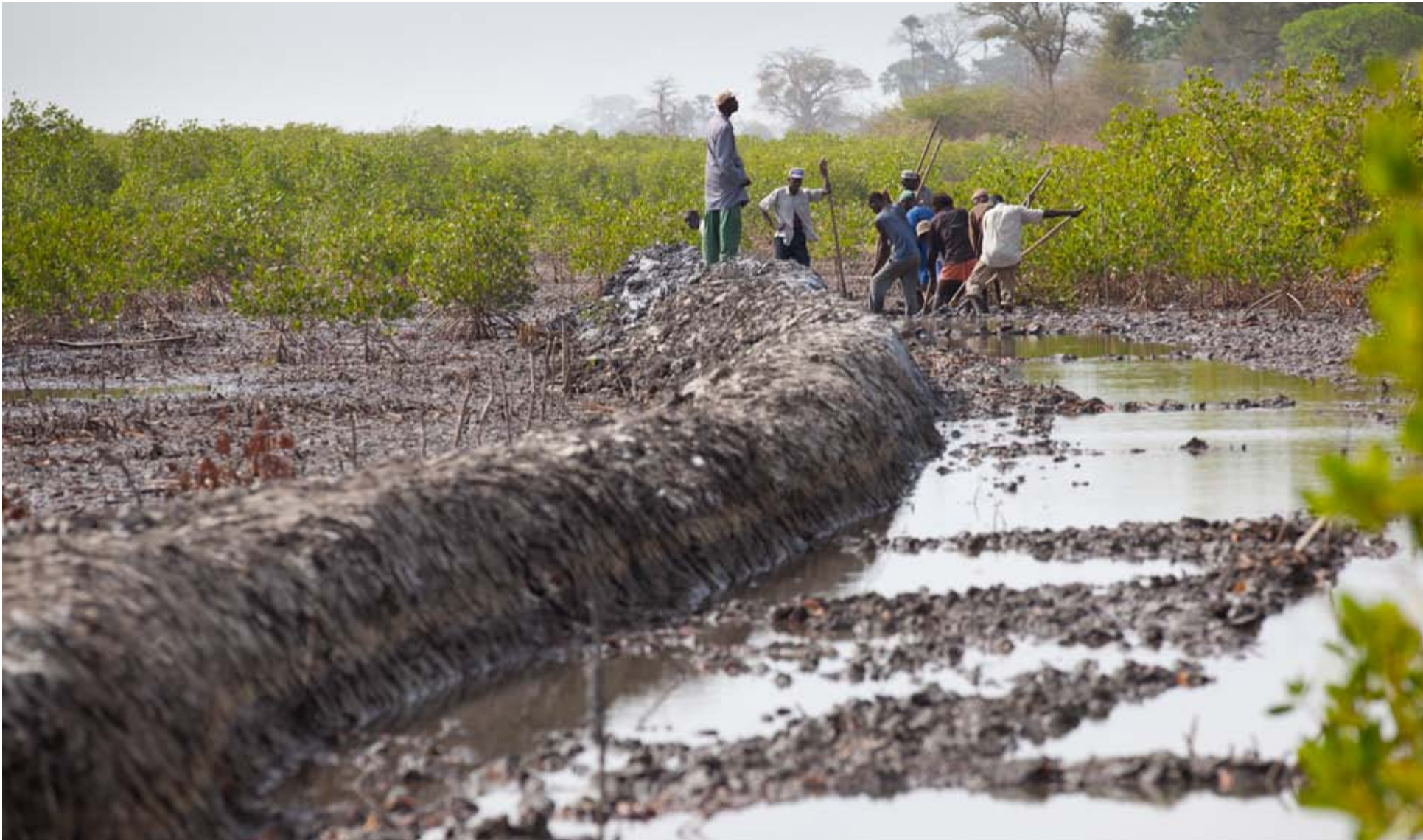
Construction d'une digue de protection des rizières en Casamance (Sénégal)
