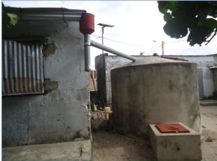
Photo 2 : Dispositif de collecte d'eaux pluviales au niveau de Falia
