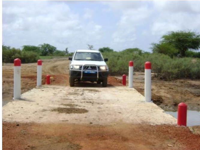
Figure 4 : Vue du pont reliant Thiafoura et Somone
